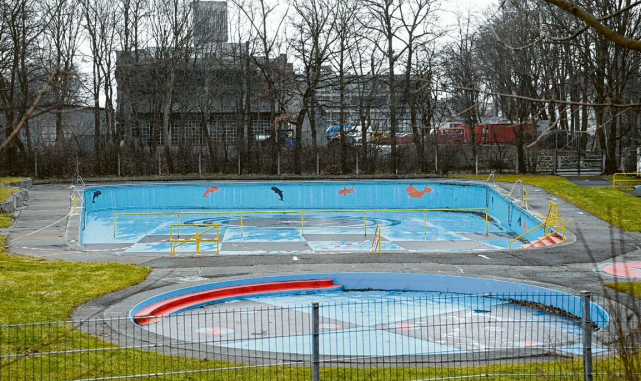
Erst wenn das Freibad Lechhausen an die städtische Kanalisation angeschlossen ist, kann es wieder eröffnen.
